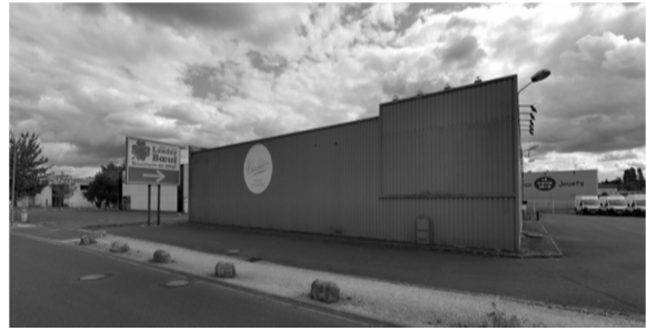
Fig.11 - revêtement sombre sur bardage métallique
