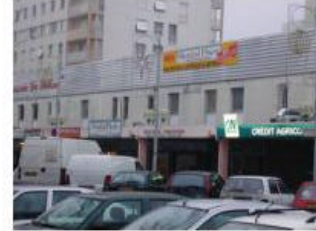
Vue sur les commerces en façade
